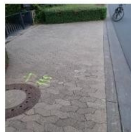
Merzenicher Str. 16, Stabilisierung zur Überfahrt des Umbachs nicht wieder eingebaut.
