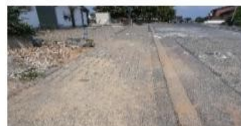
Merzenicher Str. 16, Stabilisierung zur Überfahrt des Umbachs nicht wieder eingebaut.
