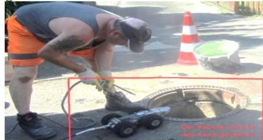
Der Roboter wird in den Kanal gelenkt
